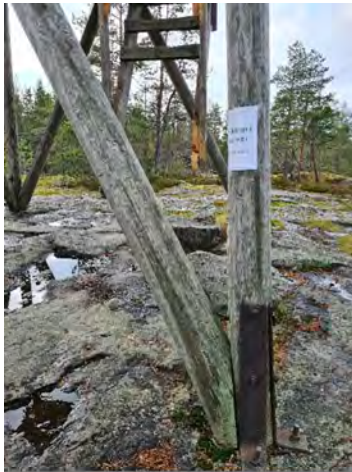
Kuva 3 Paalujen ankkurointi
