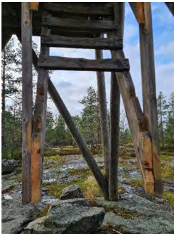
Kuva 12 Katkaistut reisilankut
