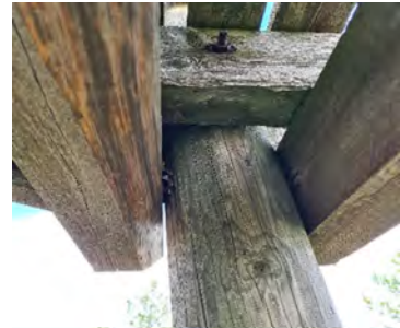
Kuva 11 Bulldog levy liitoksessa
