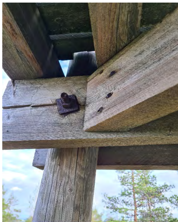
Kuva 28 Ylätason tuennan kiinnitysdetalji
